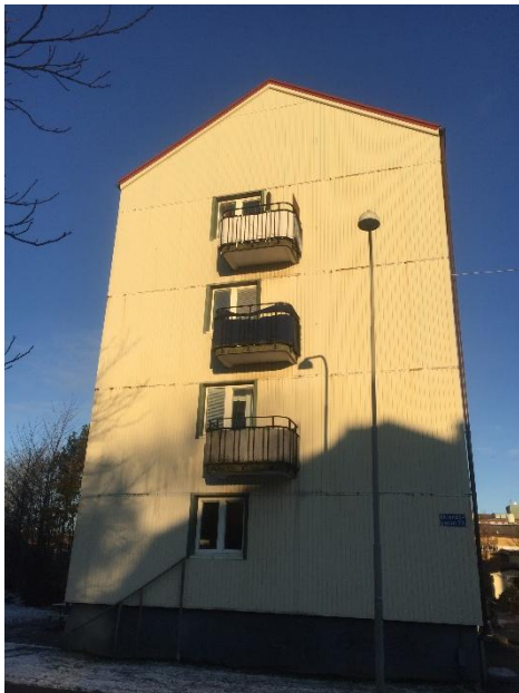
Foto 7: Gavelfasad mot söder, hus 5.
