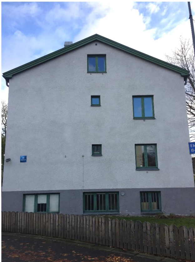
Foto 15: Fasad mot norr
