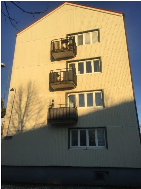
Foto 6: Gavelfasad mot söder, hus 4.
